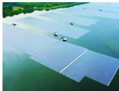
Slika 6. Plutajuća fotonaponska solarna elektrana u Singapuru [10]
