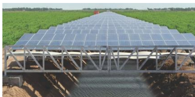
Slika 4. Solarni fotonaponski paneli nad vodonatapnim kanalima, Indija [9]
