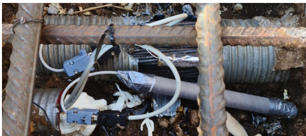
Slika 7. Postavljena mjerna traka za čelik
