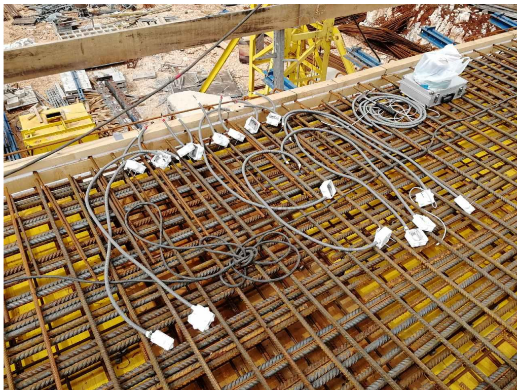
Slika 4. Pripremljene mjerne trake na mostu
