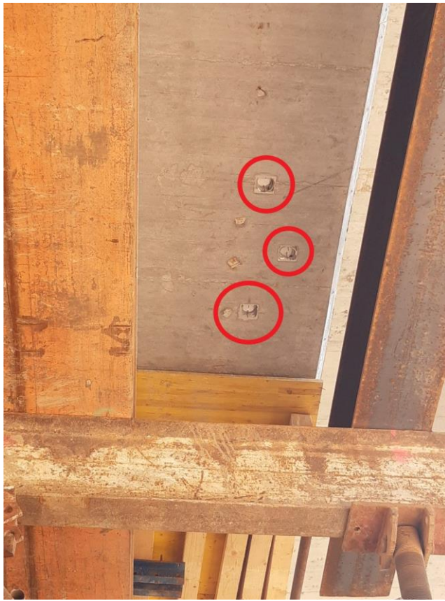
Slika 6. Vidljive kutije nakon skidanja oplata mosta – pristupačni mjerni kablovi
