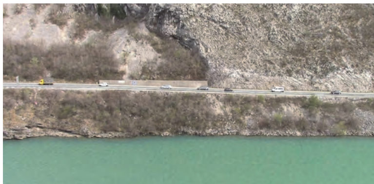
Slika 3. Snimanje videokamerom na lokaciji 5
