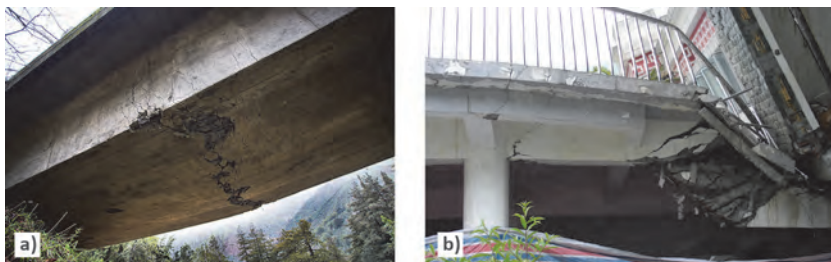
Slika 1. Mehanizam sloma a) savojni slom (statičko opterećenje), b) posmični slom (dinamičko opterećenje) [5]
